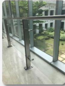
Railing sekeliling jendela kaca dan tanggac bahan stainless steel dan kaca tempered 1,2mm
