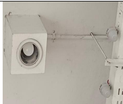
Pemasangan Sensor Cahaya di Selasar Gedung H
