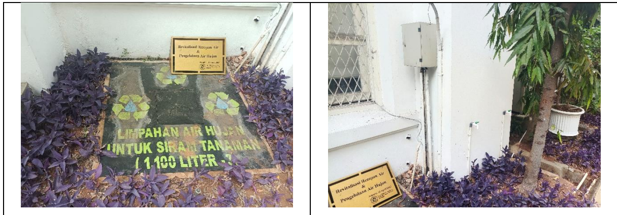
Bak Penampungan Air AC Gedung H FKUI jadi satu dengan Bak Penampungan Air Hujan
