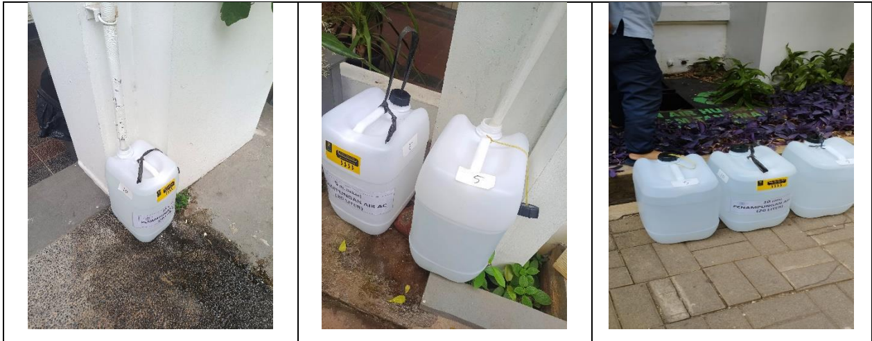
Jerigen Penampungan Air AC Gedung H FKUI
