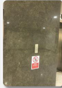
Granite tile untuk dinding toilet
