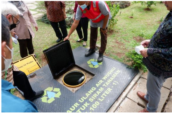
Gbr 3. Sistem Daur Ulang Air Wudhu untuk Penyiraman Tanaman
