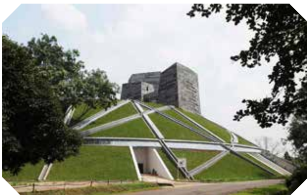
Atap hijau gedung Perpustakaan UI yang telah dilengkapi dengan panel surya.
