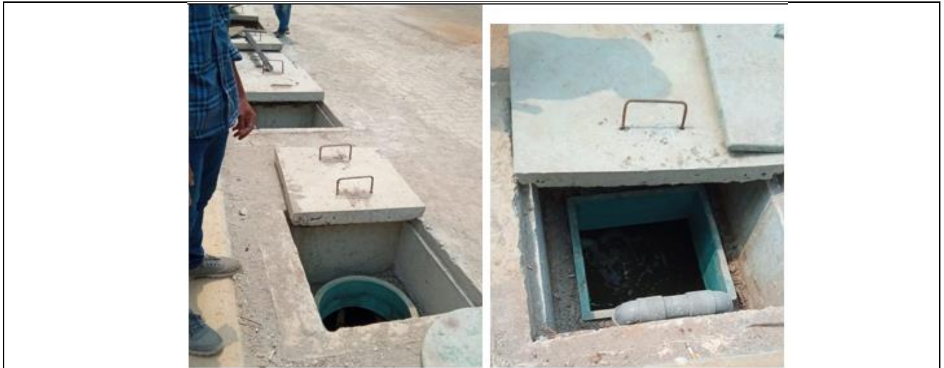
Gedung iCell FTUI sudah memiliki sistem pengolahan limbah beracun laboratorium yang diletakkan di bawah tanah.
