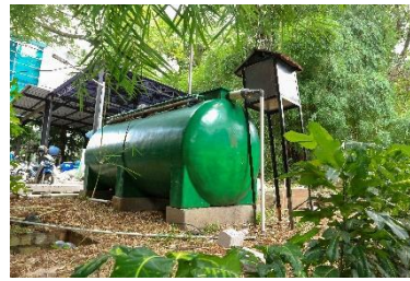
Pengolahan air limbah domestik menggunakan IPAL di atas tanah yang terpasang di Gedung Laboratorium Departemen Teknik Metalurgi dan Material (DTMM) (foto a) dan Departemen Teknik Sipil (DTS) (foto b).
