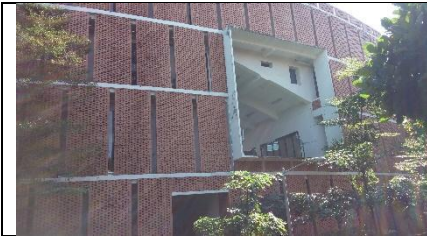
Ventilasi dan sirkulasi udara alami di Gedung MRPQ
