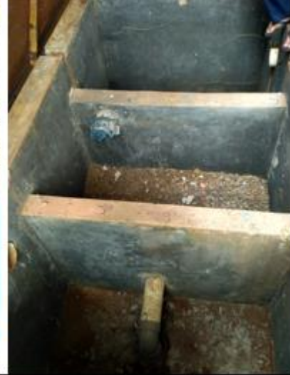
Sumur resapan yang berlokasi di belakang Gedung GK (Pusat Administrasi Fakultas), pipa talang air hujan diarahkan menuju sumur ini sehingga air hujan akan terserap kembali ke dalam tanah.
