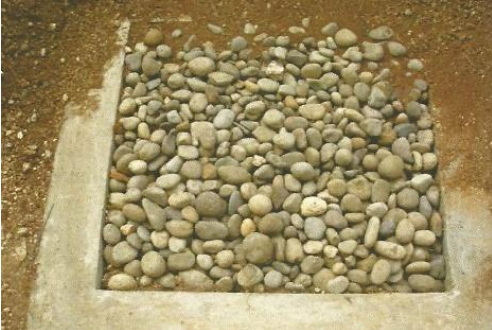
Peta distribusi lokasi sumur resapan di FTUI dengan jumlah 6 sumur resapan baru dan 21 sumur resapan lama yang direvitalisasi. Gambar dibawah peta adalah bentuk sumur resapan baru.
