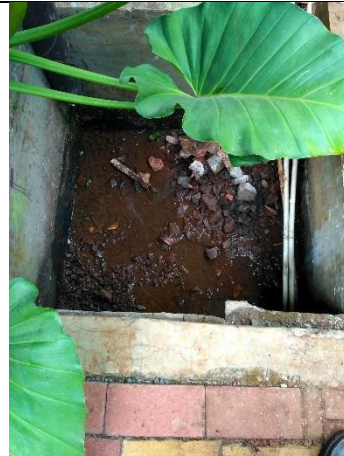
Sump Pit beton pada saluran pembuangan air hujan di Gedung Dekanat yang diubah/dialihfungsikan menjadi sumur resapan.
