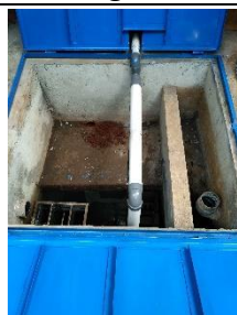
Pengolahan air limbah domestik menggunakan IPAL di atas tanah yang terpasang di Gedung Laboratorium Departemen Teknik Metalurgi dan Material (DTMM) (foto a) dan Departemen Teknik Sipil (DTS) (foto b).
