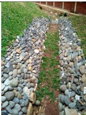
Saluran air hujan tanpa di beton atau tanpa semen dengan sistem resapan dari celah celah batuan di Gedung DTS.
