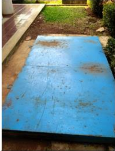
Sumur resapan yang berlokasi di belakang Gedung GK (Pusat Administrasi Fakultas), pipa talang air hujan diarahkan menuju sumur ini sehingga air hujan akan terserap kembali ke dalam tanah.
