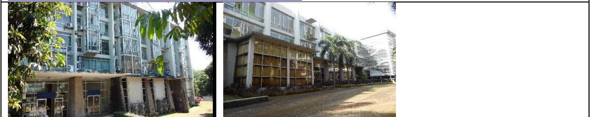
Pencahayaan alami pada Gedung Engineering Center dan Gedung Pascasarjana FTUI
