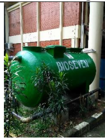
Pengolahan air limbah domestik menggunakan IPAL di atas tanah yang terpasang di Gedung Laboratorium Departemen Teknik Metalurgi dan Material (DTMM) (foto a) dan Departemen Teknik Sipil (DTS) (foto b).
