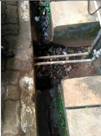
Sump Pit beton pada saluran pembuangan air hujan di Gedung DTMM diubah/dialihfungsikan menjadi sumur resapan.
