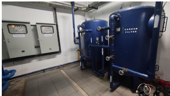
Sistem Sewage Treatment Plant dan Water Treatment Plant yang berada di dalam Ruang Pompa Gedung Utility FKUI
