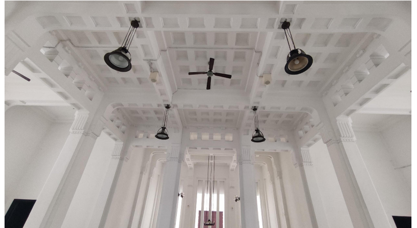
Lampu Lobi Atas Gedung H
