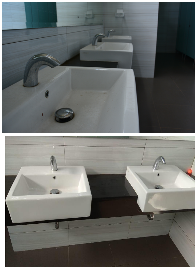
Gambar.1 Keran sensor otomatis di gedung Lab. Multi Disiplin Pertamina
