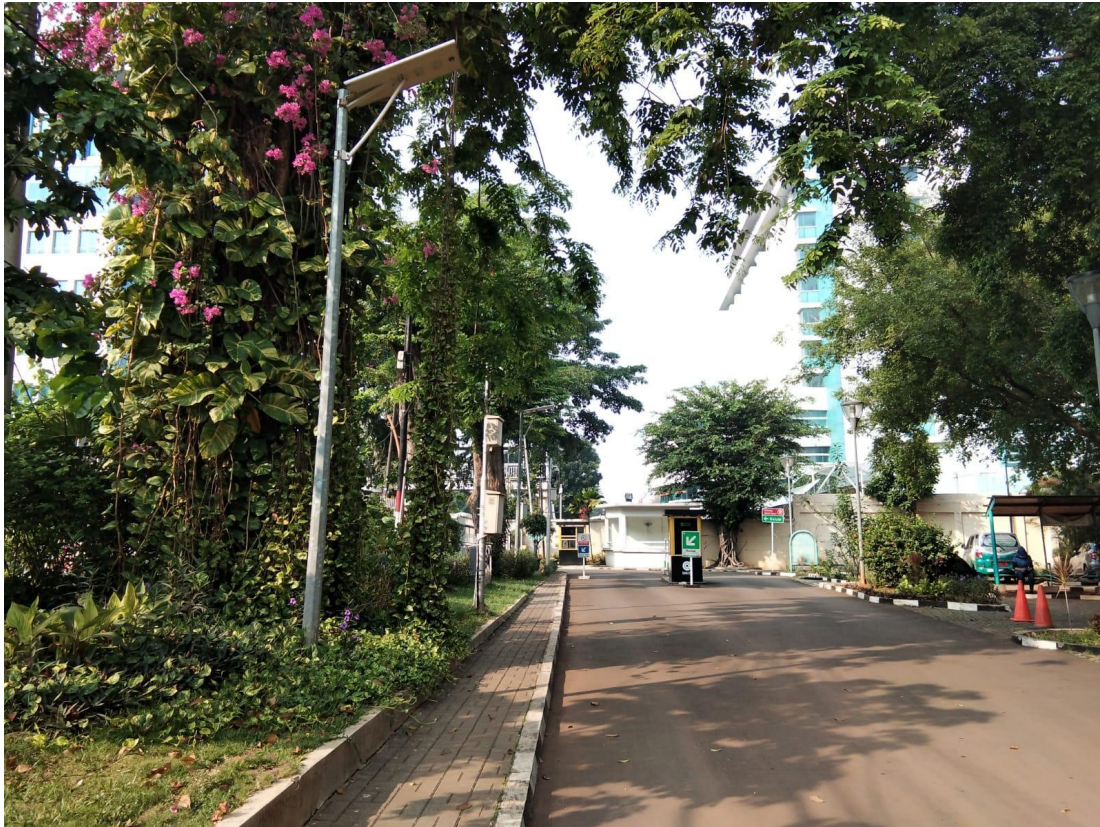
Lampu Jalan dengan Solar Panel ( Solar cell )
